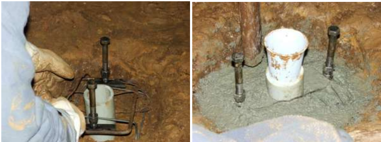
A kialakított észlelő kút fedelének betonozása
