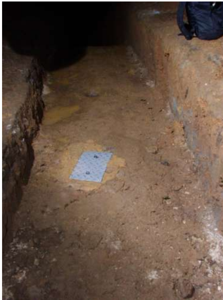
Az észlelő kút saválló fedéllel lezárva
