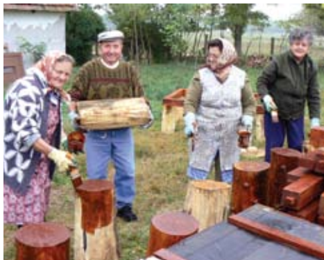
Tanösvény építése nyugdíjasok bevonásával (Rösztke)
