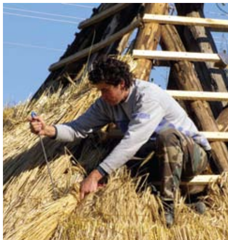
Zsúptető készítése (Oszkó)
