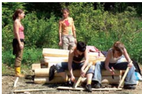
Tanösvény építése (Vác)
