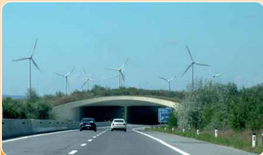
27. kép Az autópályák áthatolhatatlan akadályt jelenthetnek az élővilág számára. A káros hatások megfelelő műtárgyak (vadátjárók, zöldhidak) beépítésével mérsékelhetők.
